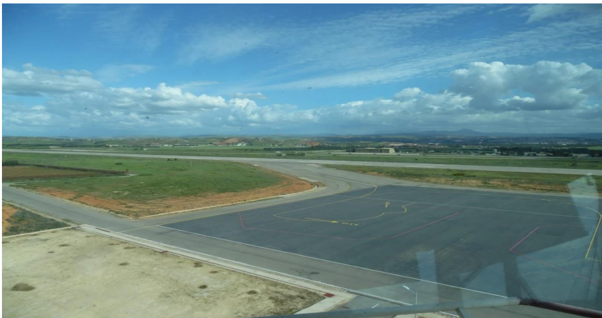
Figure 5 .2 : extension Est du parking avions et la nouvelle voie de circulation.
