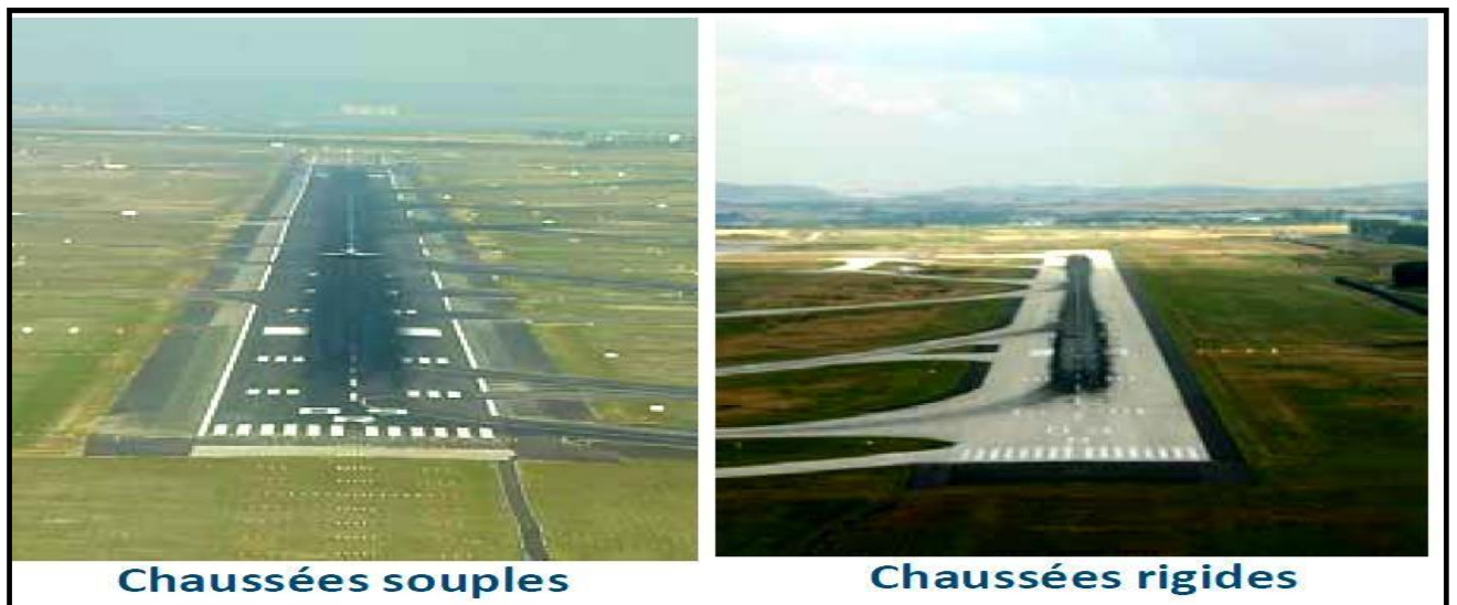
Figure 2.7 : Types des chaussées aéronautiques.
