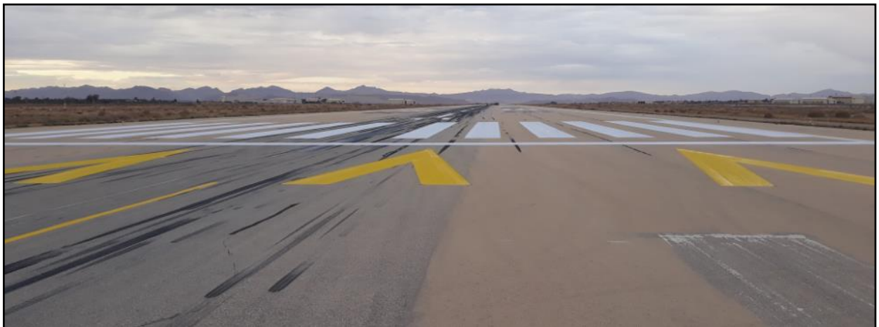
Figure 2.16: Marques de seuil 31 décalé de la piste.
