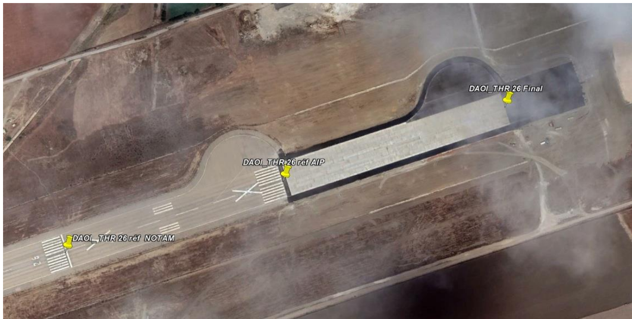
Figure 4 .4 : Image satellitaire du bout bétonné 26 en cours de réalisation.
