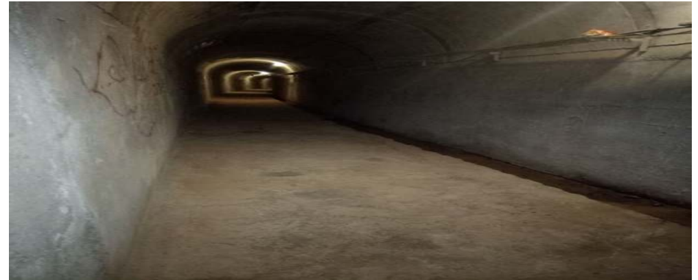
Photos 03 : la galerie du barrage
