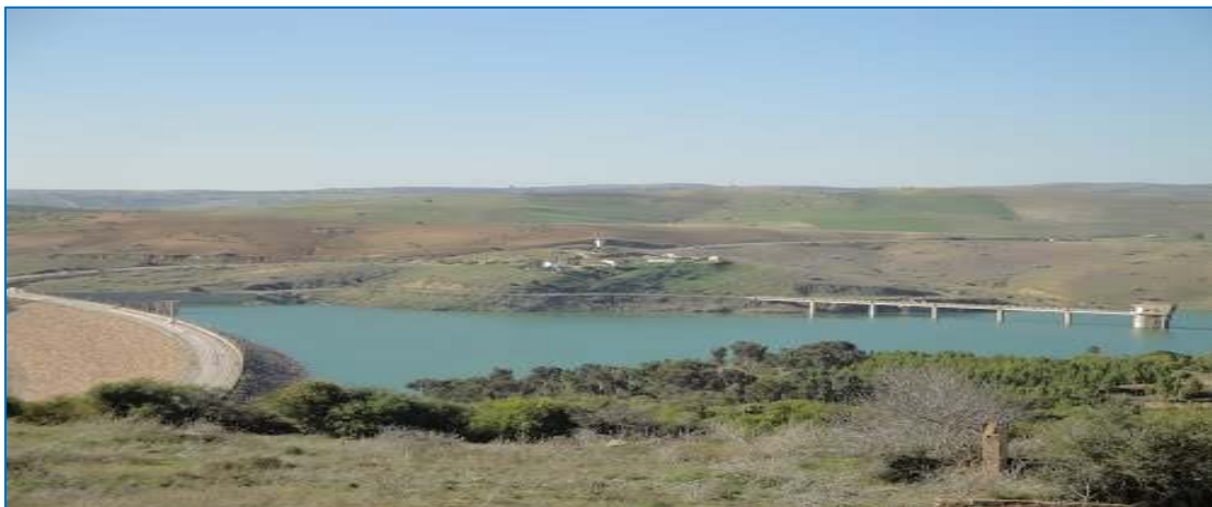
Photo 1: Le Barrage d'EL IZDIHAR
