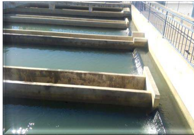
Photos 22 : les bassins de filtration
