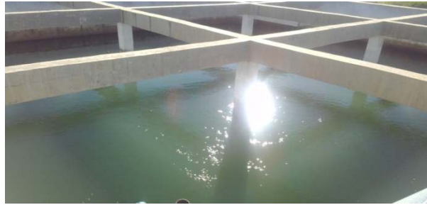
Photos 12 : le réservoir d'eau brute
