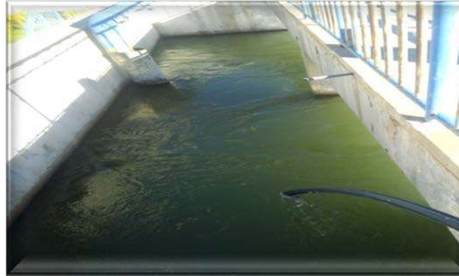
Photos 19 : Le bassin de coagulation
