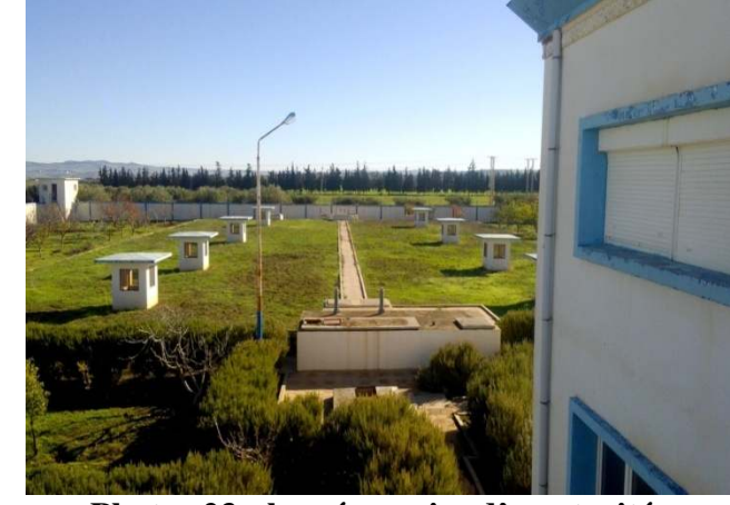
Photos 23 : les réservoirs d'eau traitée
