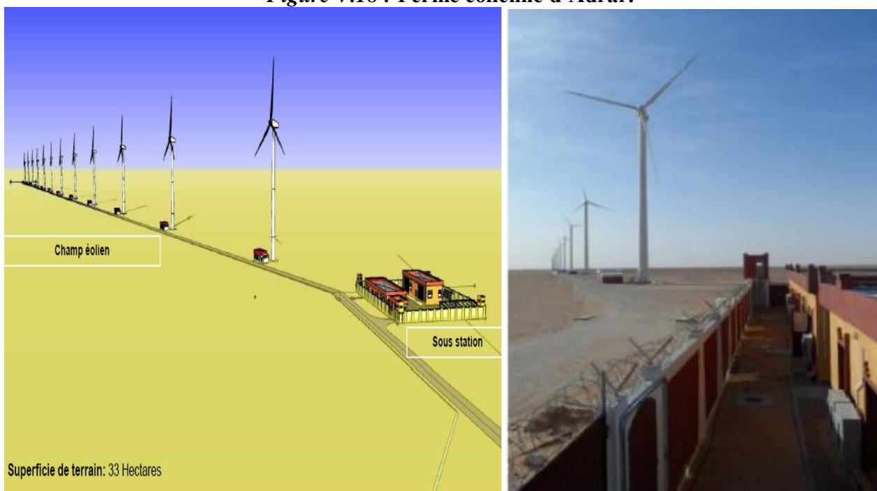
Figure V.18 : Ferme éolienne d'Adrar.
