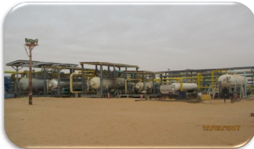
Figure III.14.a : les séparateurs de centre GS-1
