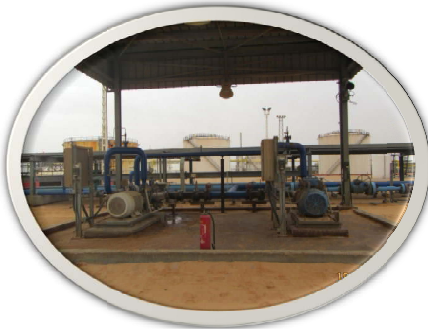
Figure III.20 : Pompe «booster» d'Eau Produite
