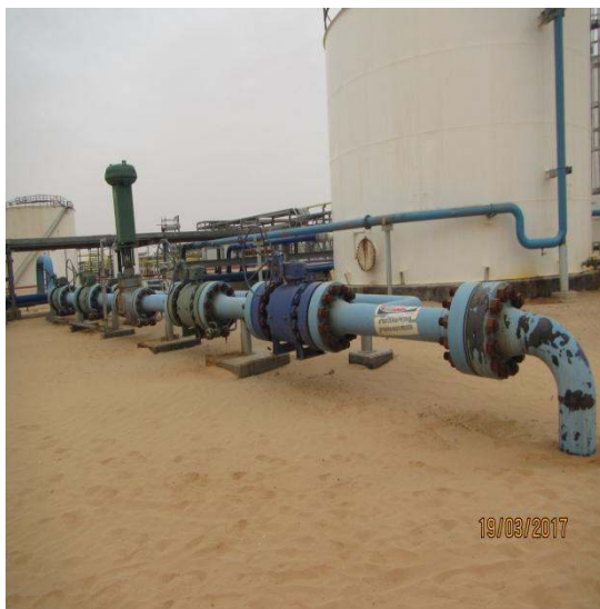
Figure III.25.a : ligne d'injection d'eau. Figure III.25.b : Puits poubelle (GS15) [9] .
