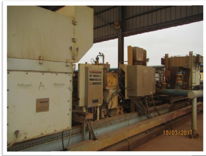
Figure III.23 : Pompe d'Injection d'Eau Produite.
