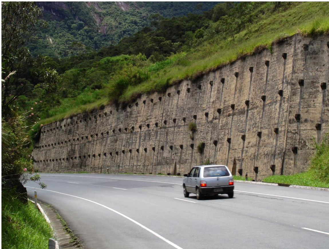
Fig.VI.13 : mur de soutènement (Keermuur)
