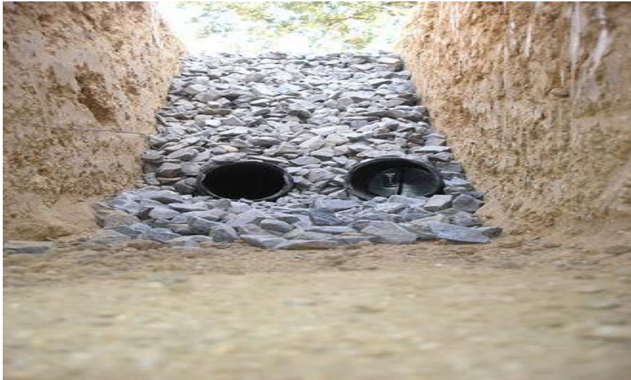
Fig.VI.15 réalisation de drainage
