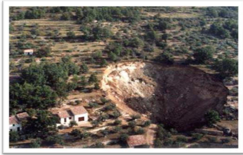
Fig.IV.15 : Effondrement d'une cavité naturelle par dissolution du gypse Bargement. France [1996].
