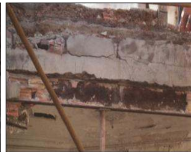
Figure II.20 : Vue sur une poutrelle métallique qui vit ses derniers instants, elle a rempli son office pendant plus de cent ans. Source : revue AMENHIS N°17
