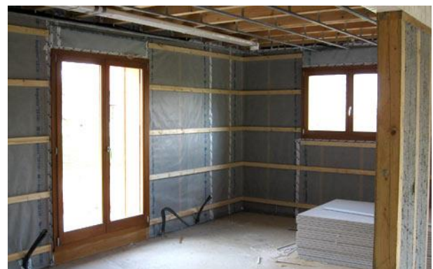
Figure 33: Isolation Thermique par Intérieur Source : isoleco.fr
