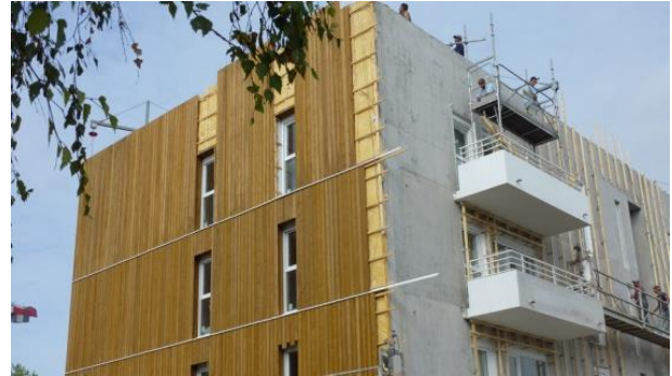
Figure 34: Les systèmes d'isolation par l'extérieur Source : www.lemoniteur.fr
