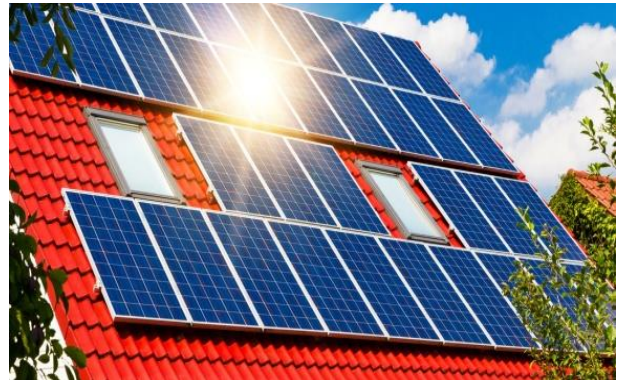
Figure 22: L'intégration des panneaux solaires. Source: www.prix-travaux-m2.com
