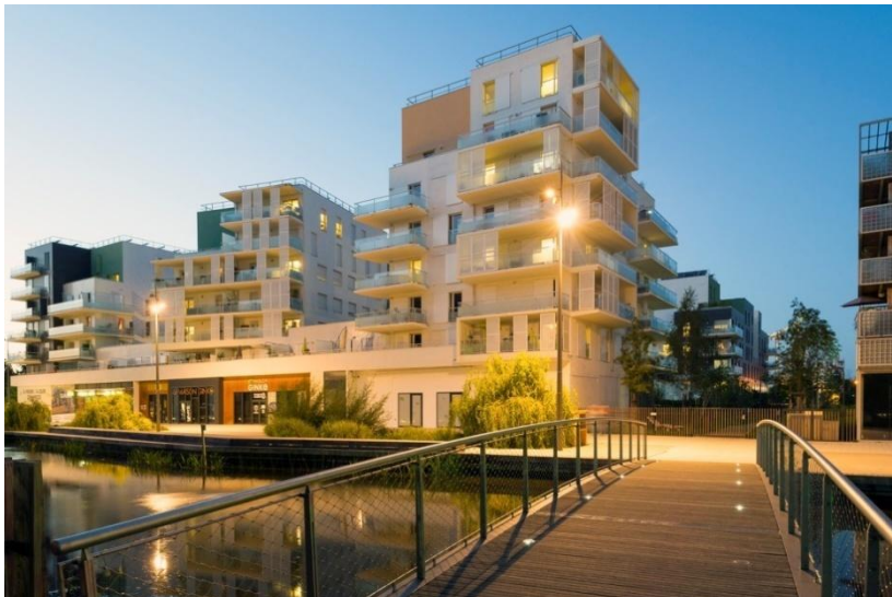
Figure 25: Vue sur l'écoquartier Ginko à Bordeaux /Source: http://www.agencedevillers.com/archives/683
