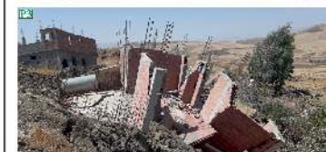
FIGURE 5.12 – Carte montrant le quartier sinistré d’El Kherba à l’ouest de la ville de Mila. La zone encadrée en rouge est la plus endommagée. P1 à P6 la position de quelques photos du glissement et des maisons détruites (source CRAAG-Sétif).
