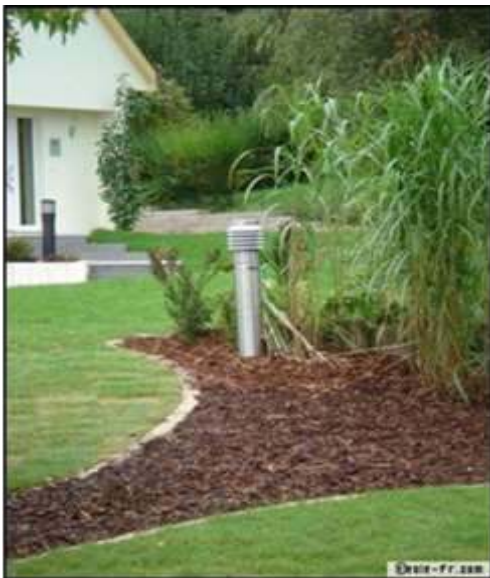
Figure 10 : puits provençal (ou canadien)
