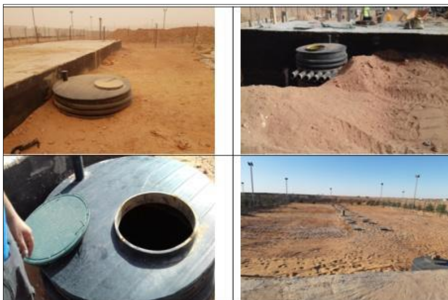
Figure II.25 : Boîte de répartition
