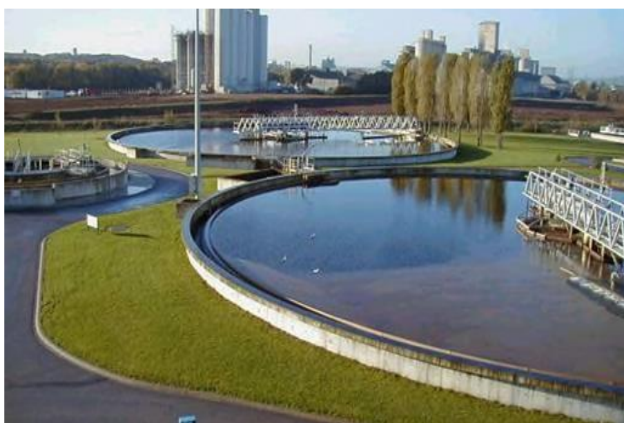
Figure I.12 : Décantation secondaire
