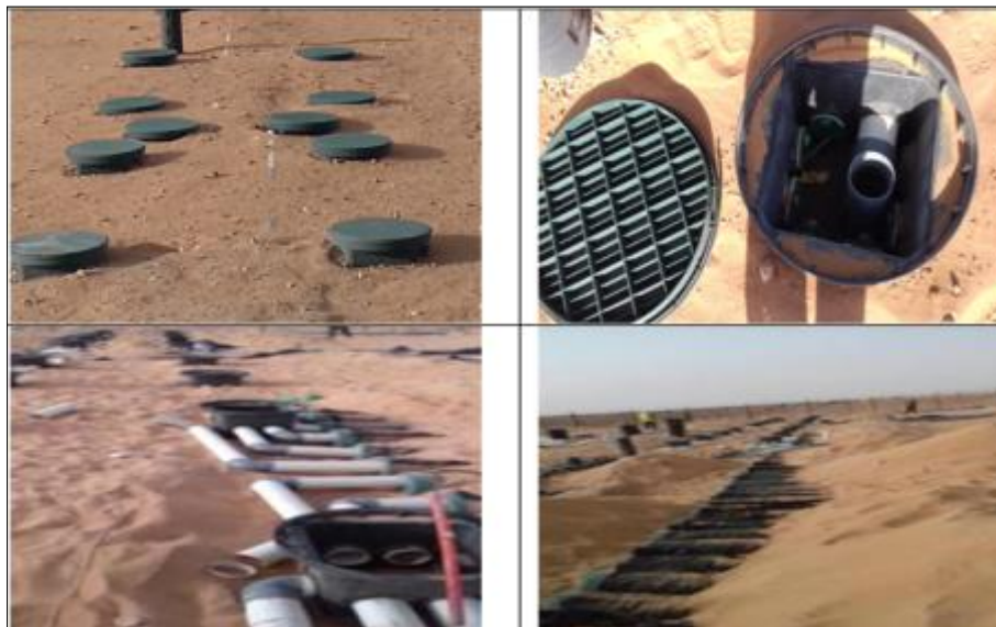
Figure II.26 : Les conduites EnviroSeptic
