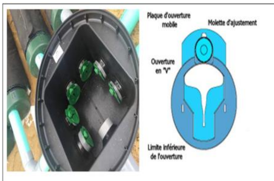
Figure II.14 :Représentation de la boîte de distribution
