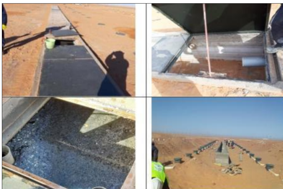
Figure II.20 : Dispositif de répartition
