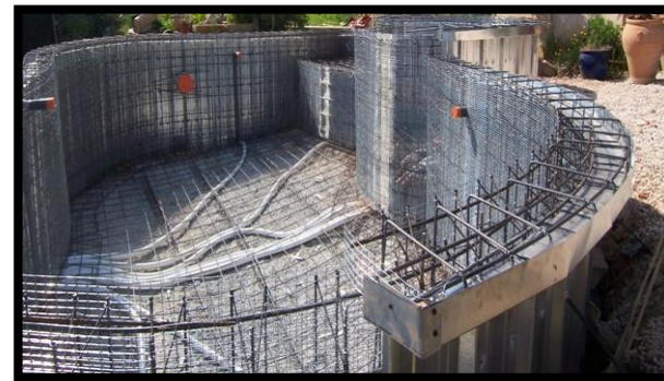
Fig16 :photo représente une structure en béton armée ;Src : livre Constructeur bâtiment , tome 2
