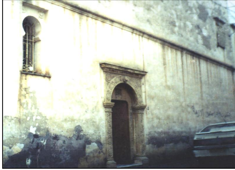
(صورة: 67) الواجهة الرئيسية .
