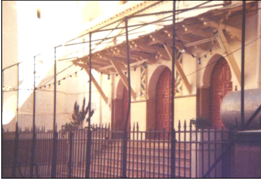
( صورة : 22) الواجهة الرئيسية .
