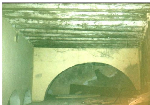
(صورة :134) العقد الذي يرفع السقف الأصلي و تظهر إلى يساره عقود البائكة .
