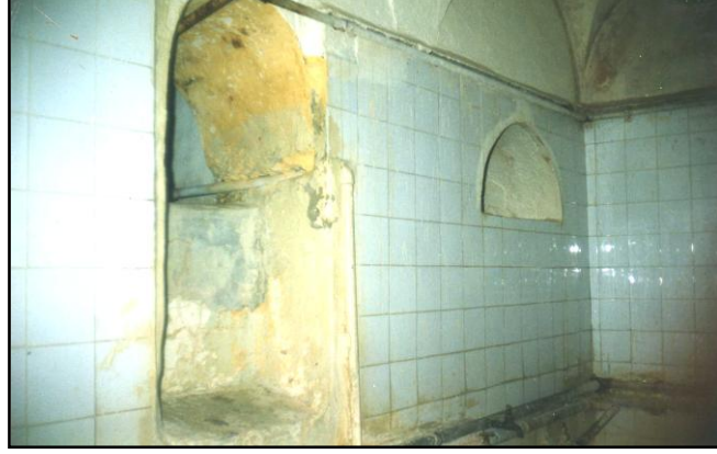
(صورة : 142) فتحة البرمة إلى جانبها فتحة الخزان المائي .
