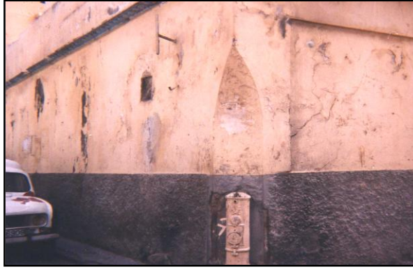
(صورة : 118) الواجهة الشمالية الغربية
