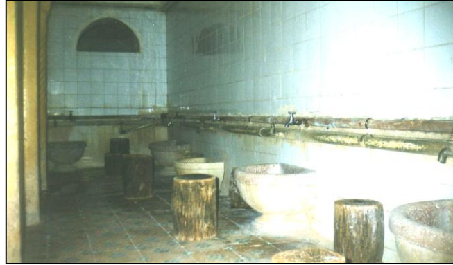
(صورة : 143 ) رواق من أروقة القاعة الساخنة ، تثبت على جداره أنبوبي الماء الساخن و البارد .
