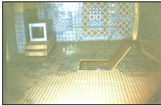
(صورة: 130) فتحة خزان الماء في أرضية القاعة الباردة .
