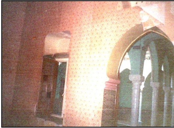
(صورة: 88 ) جانب من غرفة .
