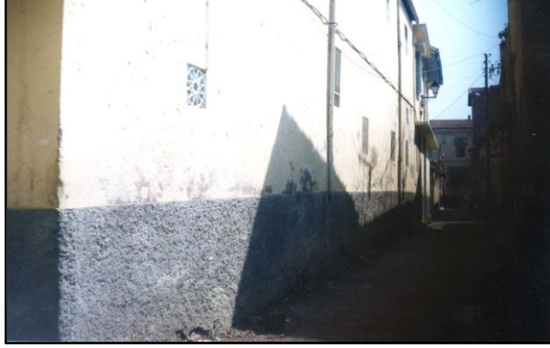
(صورة : 117 ) الواجهة الجنوبية الشرقية
