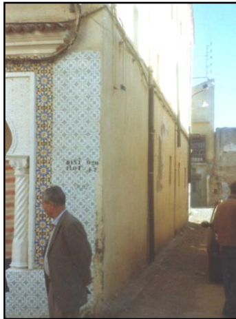
(صورة : 103) الواجهة الجنوبية الشرقية
