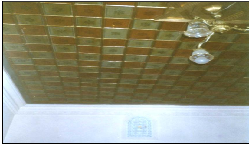
(صورة: 62) تسقيف غرفة .
