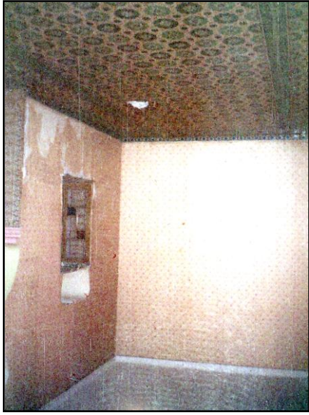
(صورة: 86 ) جانب من غرفة .
