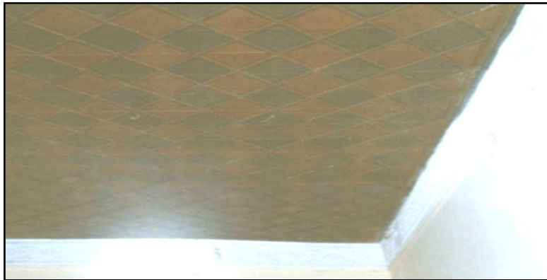
(صورة: 63) تسقيف غرفة
