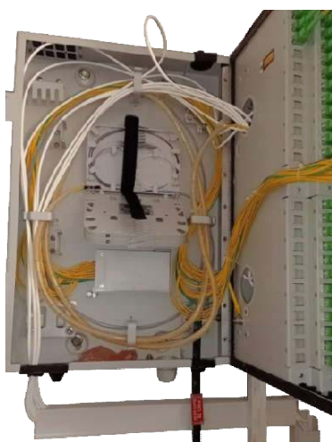
Figure I-19: Le point de branchement optique (PBO) [Algérie Télécom].
