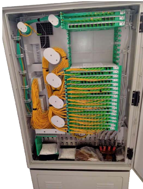
Figure I-18: Le point de mutualisation (PM/SRO) [Algérie Télécom].
