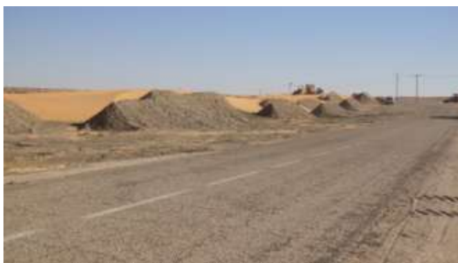
Figure 39 (a, b, c). Le site expérimental stabilisé mécaniquement par la technique des Drâas le Samedi 30 Janvier 2016 (d'après Sebaa, 2016).
