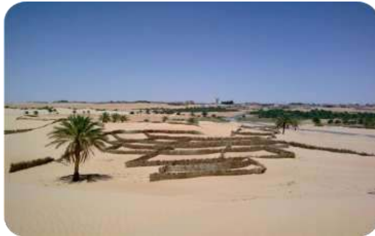
Figure 1. Carroyage de palmes destinées à protéger la section routiers d'Aïn Beïda vers Sidi Khouiled (W Ouargla) (Sebaa et al., 2015)
