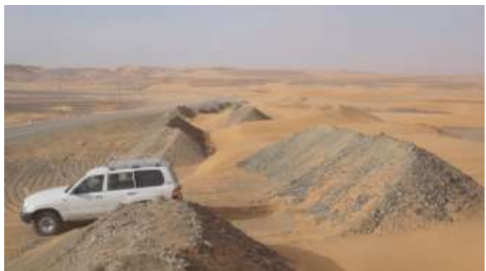
Figure 38. Vue générale d'une zone stabilisée mécaniquement par la technique des Drâas à Adrar (d'après Sebaa, 2016).
