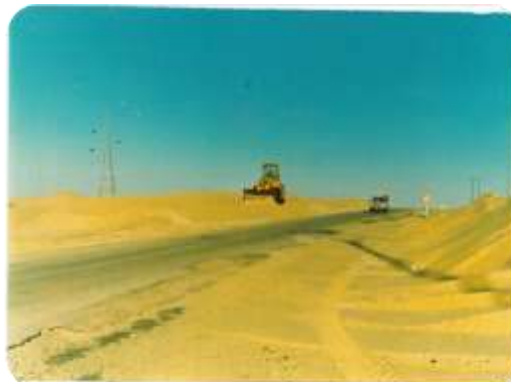
(c) Moyen d'intervention pour le désensablement
