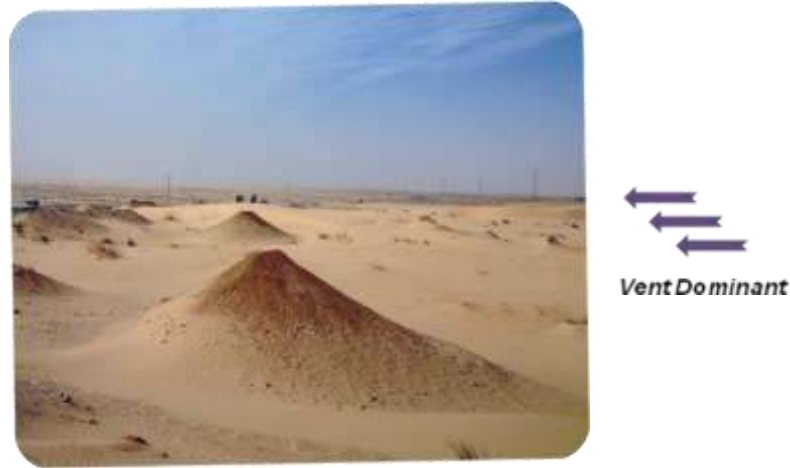
Figure 24.L'efficacité de la méthode des cônes sur la route nationale RN 16 (Touggourt vers El Oued Souf) (d'après Sebaa et al., 2015).
