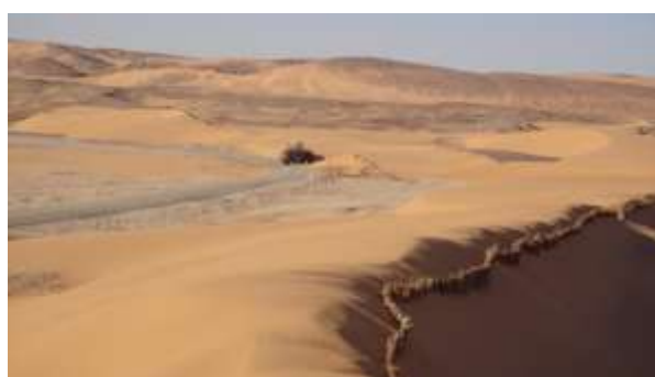
Figure 28. Site expérimentale (La section ensablée) : Route Nationale RN 51A (PK 15 + 400 – PK14), de Cherouine vers Timimoune (d'après Sebaa, 2016)
